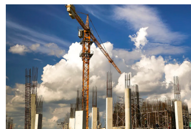
Toch-, Tief- und Ingenieurbau
